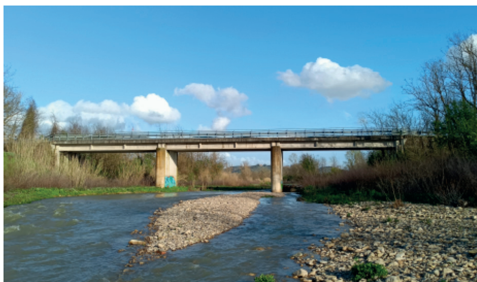
Nuovo ponte di San Vincenzo – 3 campate e due pile in alveo
