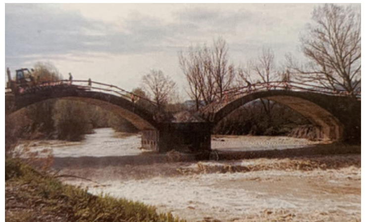
Foto 2 - Ristrutturazione del ponte Acciaoli a Cerbaia
