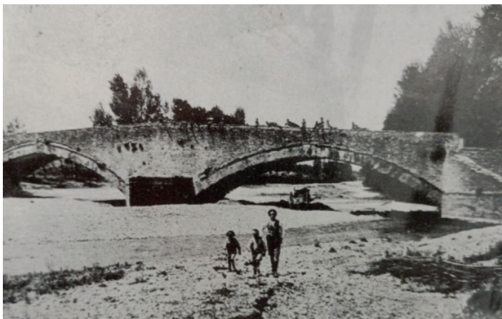
Foto 1 - Ponte di Mannino Acciaoli, 1929
