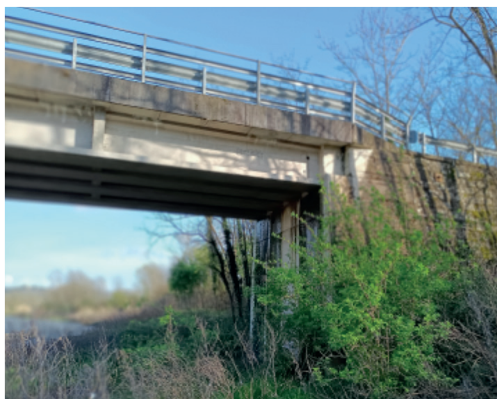
Nuovo ponte di San Vincenzo: nuova spalla sinistra addossata alla vecchia
