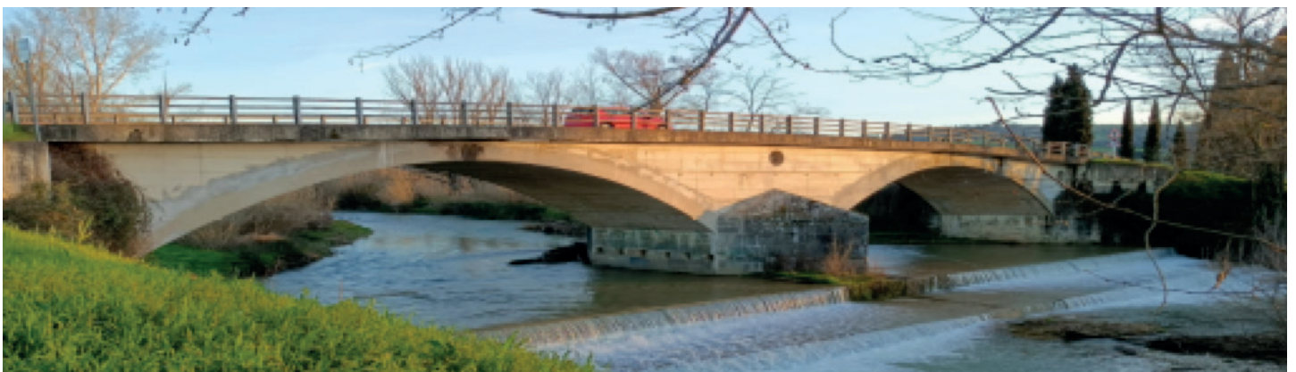
Foto 3 - Ponte Acciaioli a Cerbaia
