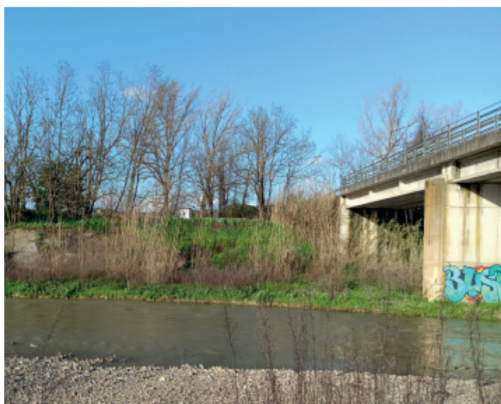
Nuovo ponte di San Vincenzo (spalla destra): specchi di difesa sponda - ultimo spezzone della traversa
