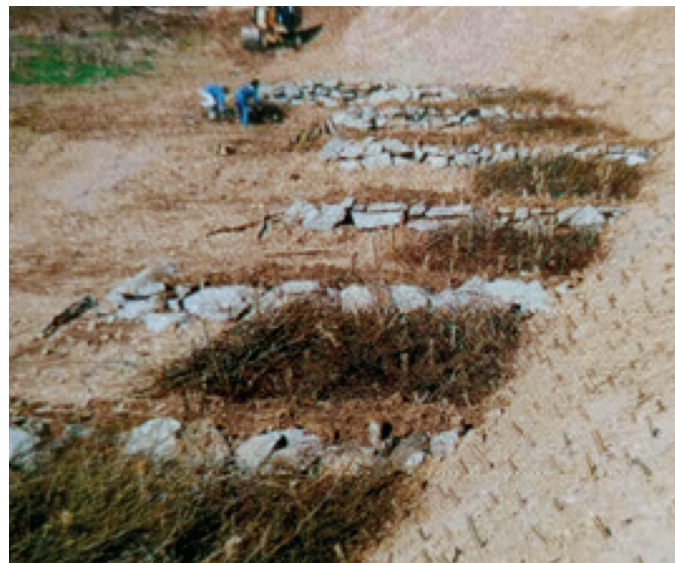
Pennelli vivi (pennelli in alveo visti da valle dopo la ricostruzione del ponte)
