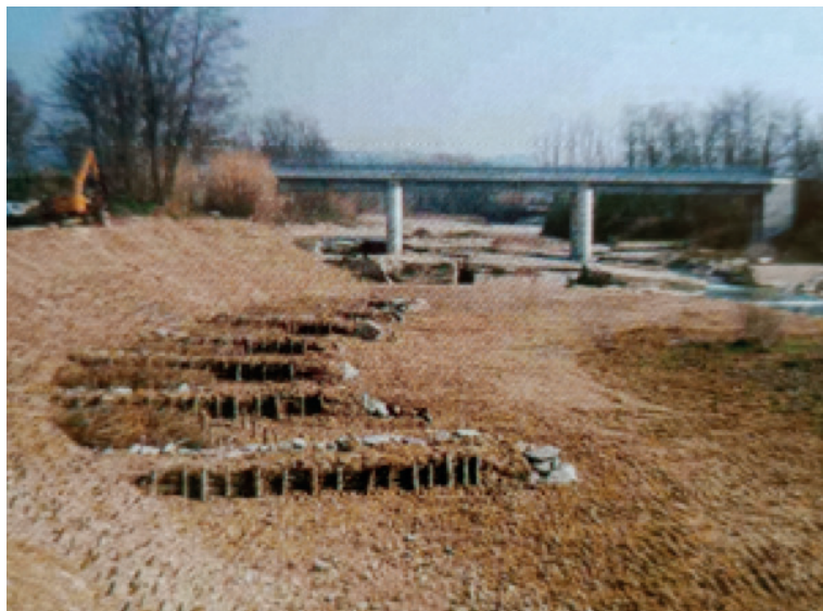
Pennelli vivi (pennelli in alveo visti da valle dopo la ricostruzione del ponte)
