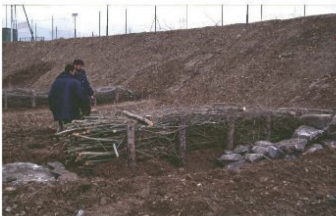
S. Vincenzo: durante i lavori di realizzazione del repellente vivo
