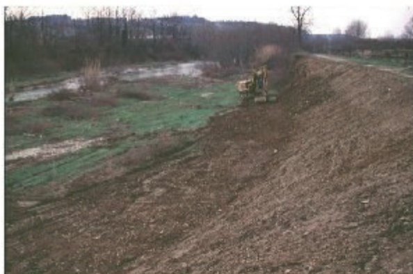
Il sito di S. Vincenzo a Torri: la prima fase dei lavori (riduzione della pendenza)
