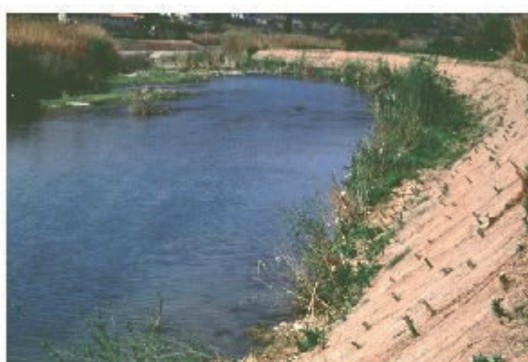
Poco dopo la fine dei lavori
