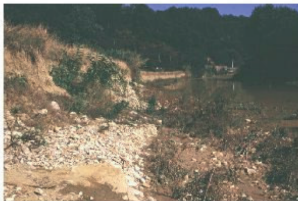
La situazione prima dell'intervento
